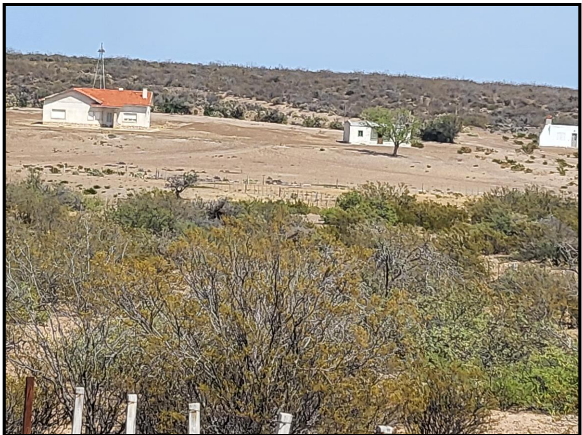
FOTO N° 2: Instalaciones del establecimieneto rural “El Gauchito”
